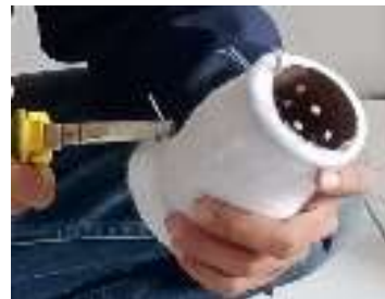
Gambar 7. Proses Pembungkusan Pipa
