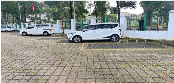
Gambar 4. Kondisi Area Parkir Roda Empat
