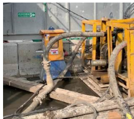
Gambar 3 Penyedotan sisa slurry polimer pada saat proses pengecoran
