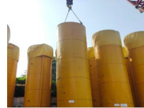
Gambar 4 Silo Dia 3,2 m dan Tinggi 18 m
