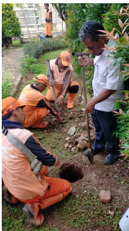
Gambar 5. Tim orens membantu pembuatan lubang biopori
